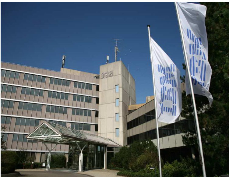
1994, Mainz, IBM Rechenzentrum
